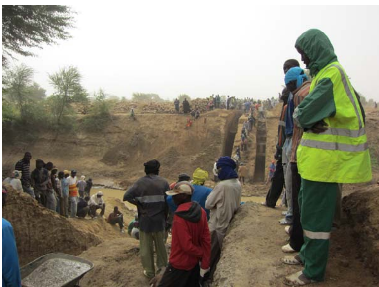
Construction du nouveau barrage
