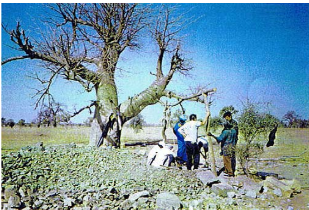
Forage d'un puits
