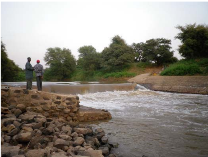
Barrage à Kabaté
