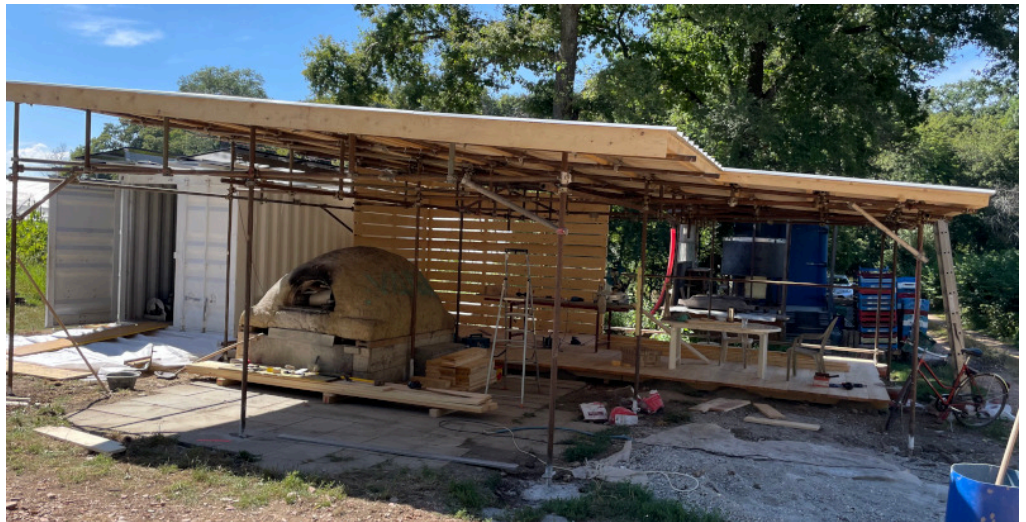
Installation photovoltaïque et création d'un espace de travail à l'abri à Drize
